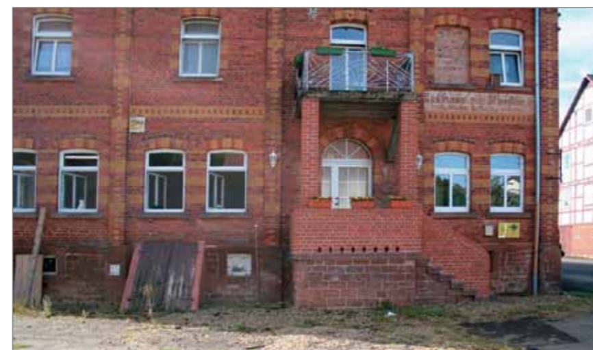
Die Katzenstation Borken. Das Tierheim ist im Erdgeschoß untergebracht.
